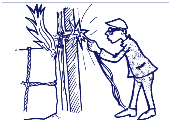
Fig. 2 - Inflammation au contact de conduites invisibles chauffées
